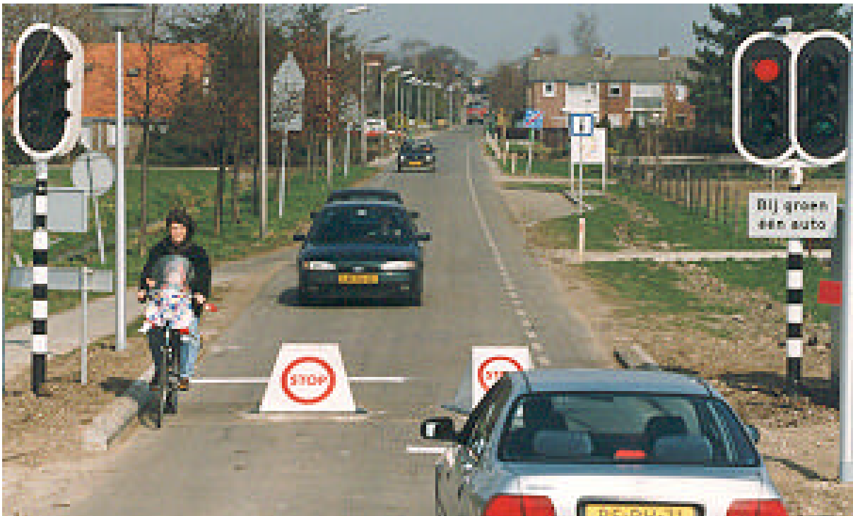
Foto van een doseerinstallatie in Vianen
