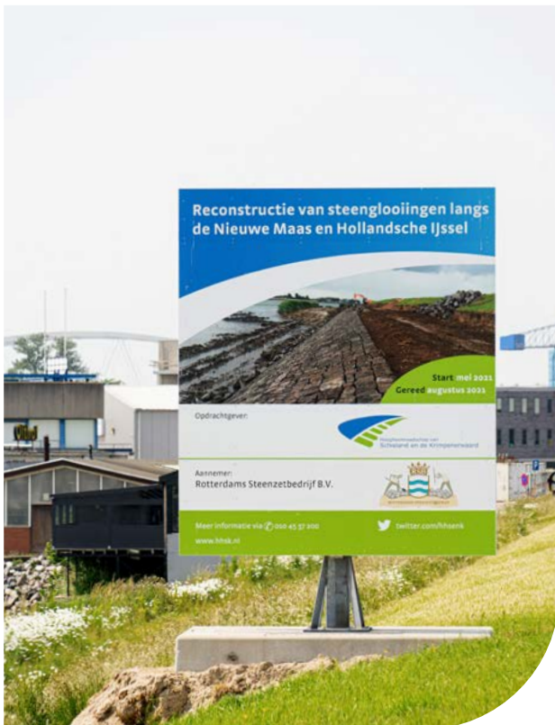
Afbeelding: Uitvoering van buitengewoon onderhoud
