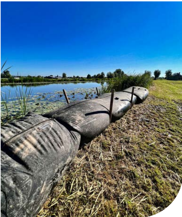
Afbeelding: De inzet van SlamDams als noodmaatregel tegen het overstromen van een regionale waterkering.
