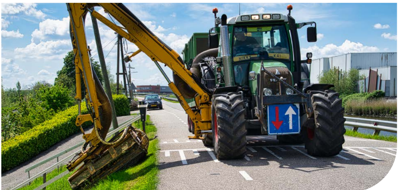
Afbeelding: Onderhoud van de dijk
