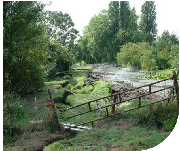
Afbeelding: Voorbeeld van een gefaalde waterkering als gevolg van het uitdrogen van een veenkade bij Terbregge, 2003
