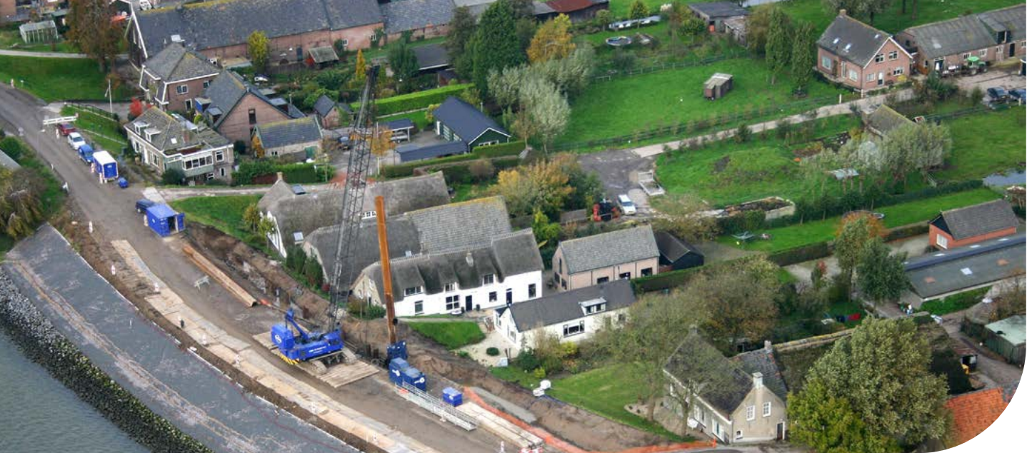
Afbeelding: Een dijkversterking in uitvoering
