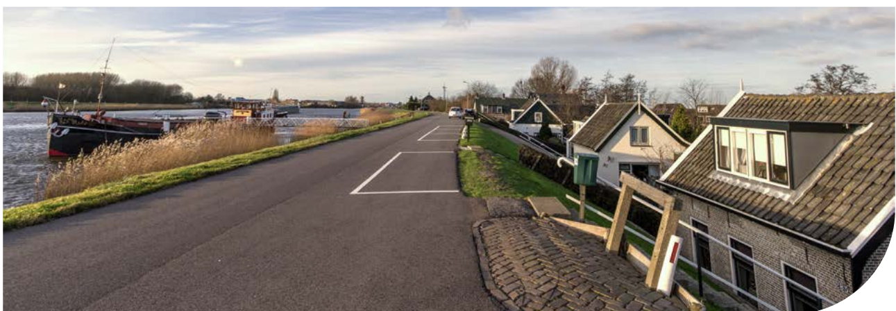
Afbeelding: Een voorbeeld van een dijk waar weinig ruimte is voor een dijkversterking.
