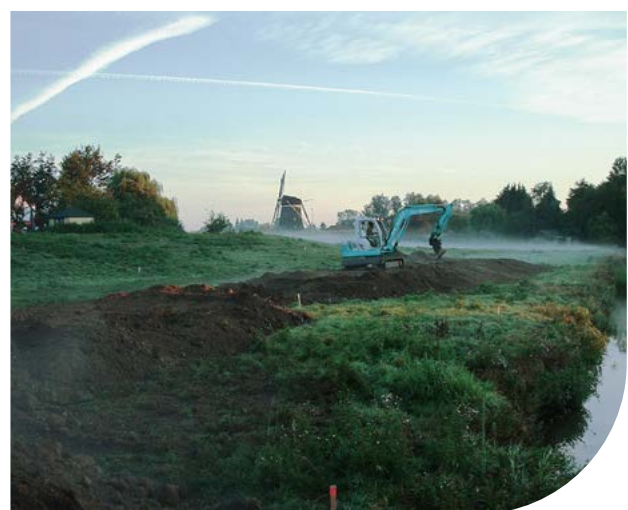
Afbeelding: Het versterken van een regionale waterkering
