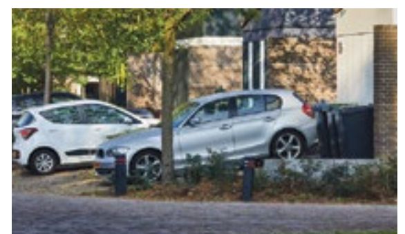
Schuine opritten door bodemdaling. (foto: Platform Slappe Bodem / Vincent Basler)
