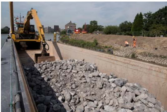
Aanbrengen stortsteen bij de Mient
